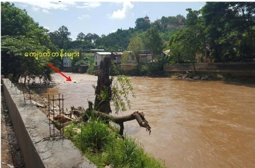
ပုန်းထွန်ရပ်ကွက်၊ ဝါးဆိပ်၊ မြန်မာ-ထိုင်း နယ်နိမိတ် ရည်ညွှန်းမှတ်တိုင် BRP(၄၉၂) အနီး မယ်ဆိုင်ချောင်း အတွင်း ကျောက်တန်းများချထားပြီး ချောင်းရေကို ဟန့်တား
