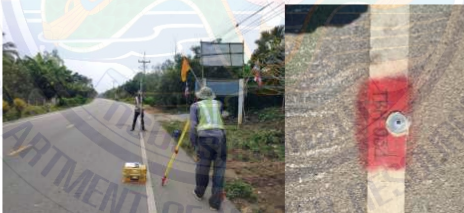
รูปที่ 4-11 หมุดชั่วคราว (TBM) ตลอดสายการระดับโครงการ
