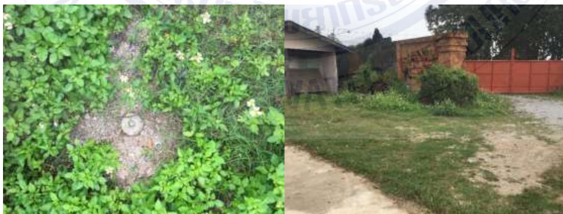
รูปที่ 3-7 หมุดหลักฐานถาวรแบบ ข. ที่นำไปฝังเสร็จแล้ว
