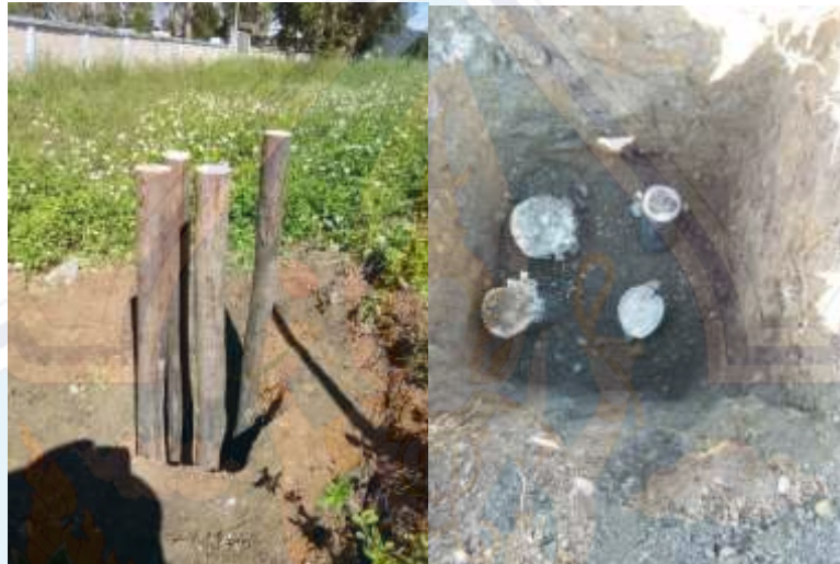
รูปที่ 3-3 เข็มไม้ตอกใช้ในการก่อสร้างหมุดหลักฐาน
