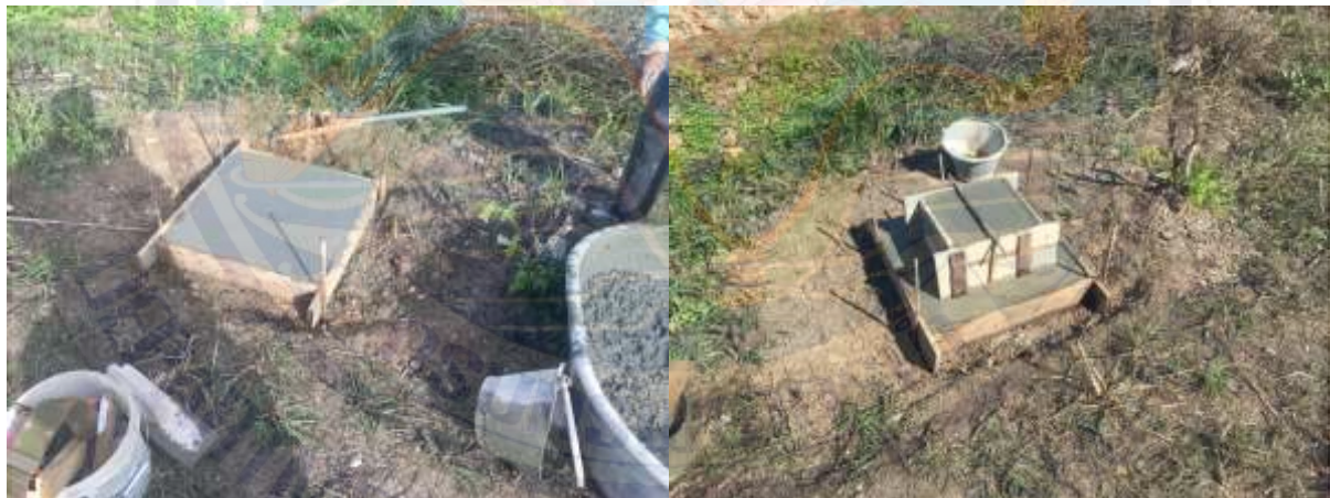
รูปที่ 3-4 หล่อคอนกรีตให้เป็นรูปทรงสี่เหลี่ยมจัตุรัส
