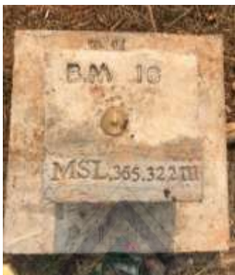
รูปที่ 3-5 หมุดหลักฐานถาวรแบบ ก. ที่ก่อสร้างเสร็จแล้ว
