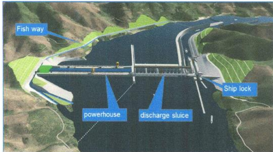
รูปที่ 2 องค์ประกอบหลักและโครงสร้างพื้นฐานโครงการไฟฟ้าพลังน้ำปากแแบง
