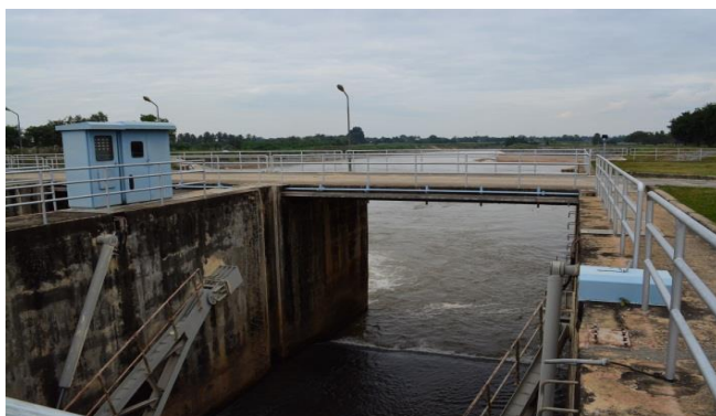
ลักษณะของอาคารและประตูระบายน้ำ
