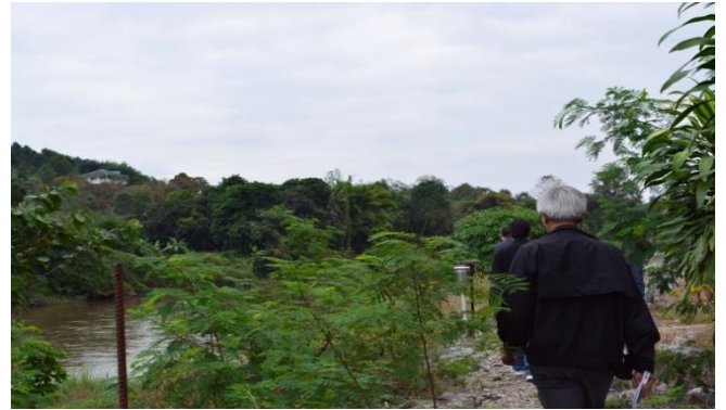
สภาพลำน้ำด้านท้ายน้ำแม่ น้ำกก บริเวณ บ. ไปงนาค่า อ.เมือง จ.เชียงราย
