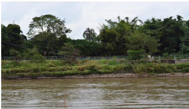
ตำแหน่งติดตั้งเครื่องมือวัดระดับน้ำ
